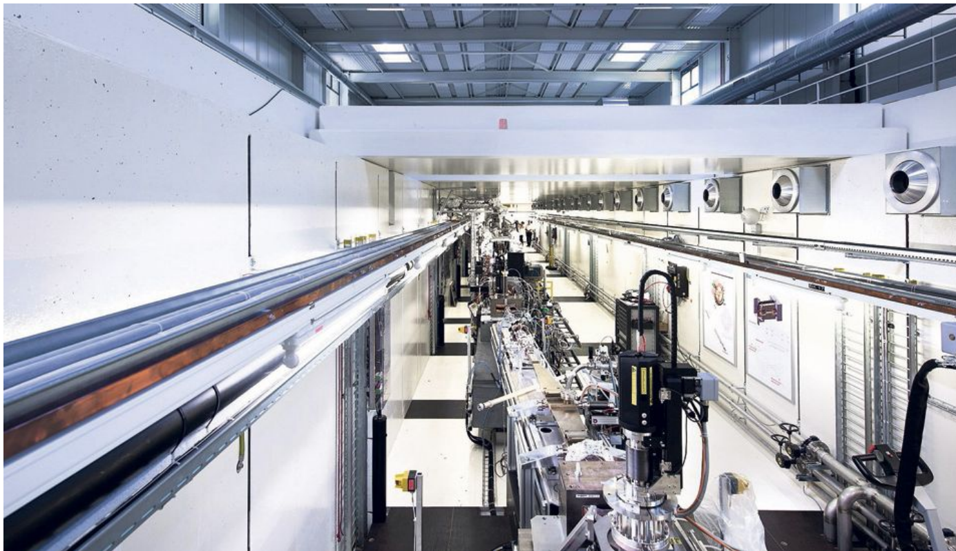
Blick auf den ersten Teil des künftigen SwissFEL-Beschleunigers, der bereits getestet und optimiert wird. (Bild: Adrian Baer / NZZ)
